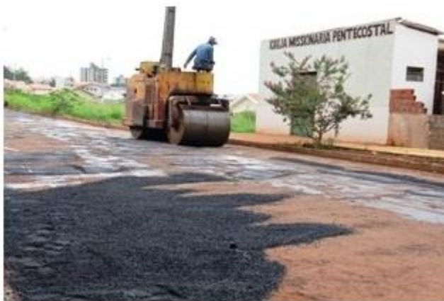
Foto de Fevereiro de 2012 mostra recape sendo realizado na Avenida Manoel Nogueira
