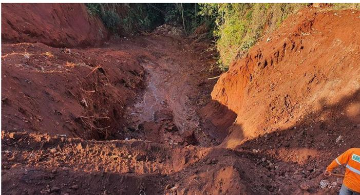
Obra de estabilização da grande voçoroca, decorrente do lançamento de águas pluviais sem galerias, abaixo da Av. Tancredo Neves, Jardim Topázio, na região do Jardim Copacabana.
