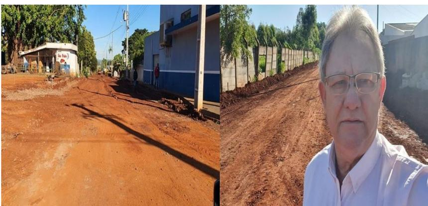
Vistoriando as obras para asfaltamento da Rua Alcides Hauagge no Jardim Santa Cruz. As galerias pluviais já foram implantadas e deve ser iniciada colocação dos meios fios, para na sequência, executar a pavimentação.
