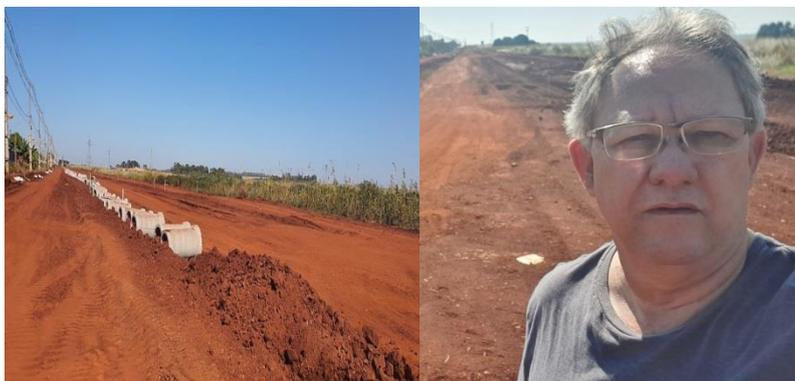
Obra de asfaltamento da Av. João Batista Salvadori no Jardim Cidade Nova. A obra está em fase de terraplanagem e implantação de galerias pluviais. Quando concluída, será uma importante via de ligação com a Santa Casa.
