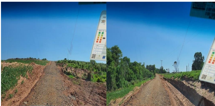
Visita à comunidade rural Alto Divino. Fui verificar o trabalho de adequação com cascalhamento que o município, através da Secretaria de Obras está executando na comunidade.
