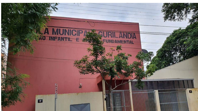
Visitei a Escola Municipal Gurilândia na área central da cidade. Conversei com servidoras, professoras e com a Diretora Ester. Falamos de assuntos da escola e das obras da nova Gurilândia que estão em andamento, com previsão para término em meados de 2020.
