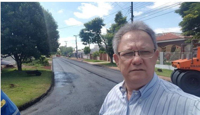
Fiscalizando a obra de recape nas diversas vias do Jardim Araucária que estão em execução.
